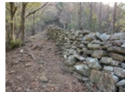
牧の遺構と考えられている「豊玉の猪垣」 豊玉町塩浜の西南の尾根に、東西約240mにわたり、高さ1.1m、上幅0.6m、下幅1.2mの石垣が築いてある。
